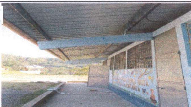
Foto 5: Fabricación e instalación de balcones, en el área de cocina, dirección del establecimiento y tres aulas.
