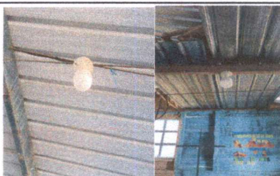
Foto 6: Sustitución de lamparas en tres aulas y el corredor del establecimiento.
