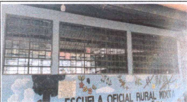
Foto 3: Sustitución de vidrios quebrados en el área de cocina, dirección del establecimiento y cuatro aulas.
